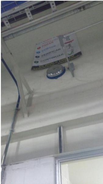
imagen 33 conducto del cableado y chicharras ya instalada
