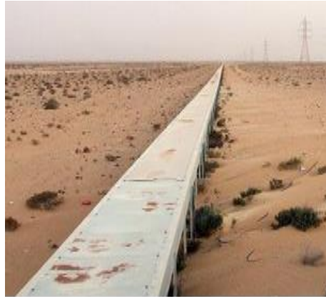
Fig. 3 Cinta transportadora para extracción de fosfatos de Marruecos
