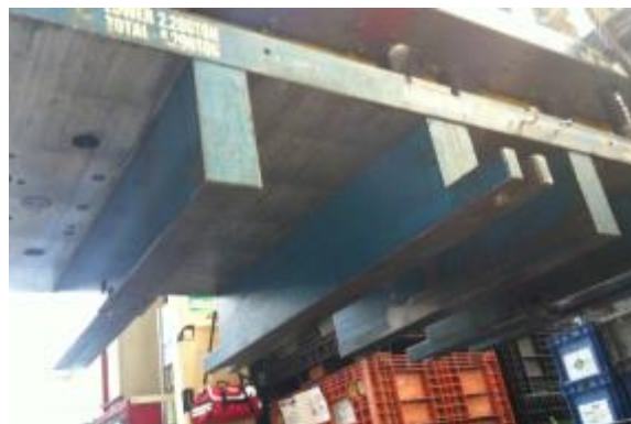
Figura 76.- Vista de los 2 centradores instalados
