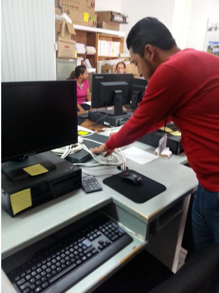
Ilustración 44: Conexión de cables
