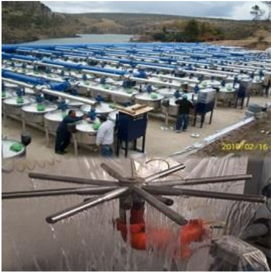
Plataforma de Filtrado
