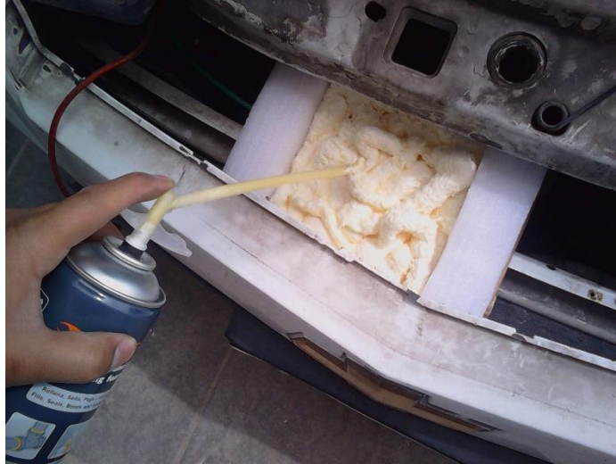
Figura 40. Inyección de poliuretano en base de celda
