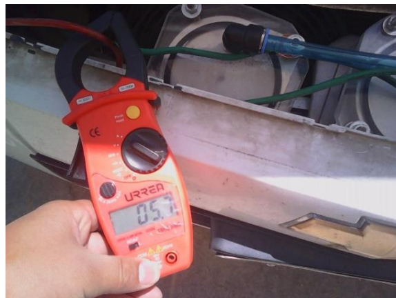
Figura 38. Medición de corriente eléctrica
