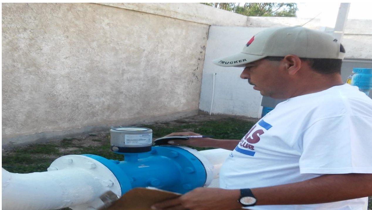
Figura 6. Toma de Lectura de Extracción en Formato Fuente: ORGOA de San Francisco de los Romo
