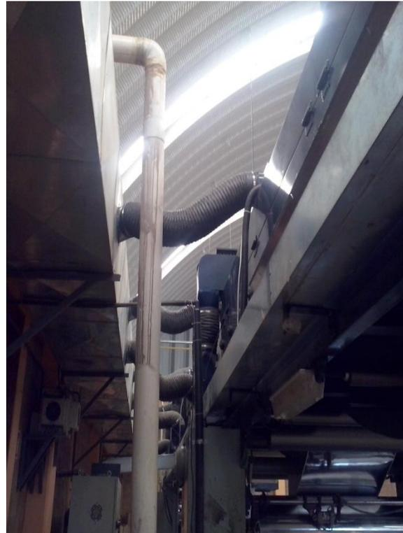
Fig. 20 Cambio de Mangueras de Extracción, Laminadora
