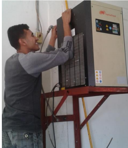
Fig.2.9: Desconexión y desinstalación del secador de aire.
