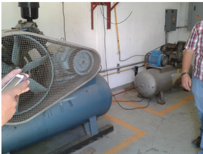
Fig.2.11: Cuarto de compresores antes de darle mantenimiento al sistema de purgación, y limpieza al cuarto.
