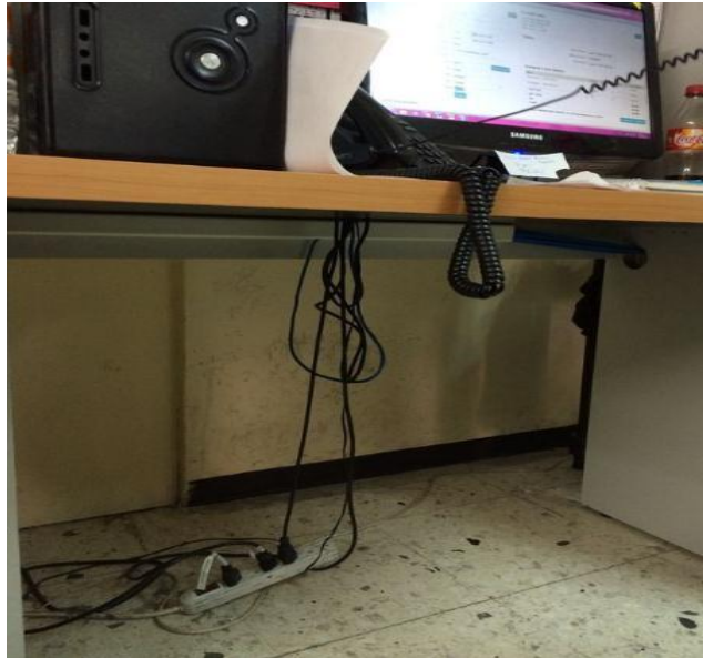
Fig.9.3 Cables expuestos.
