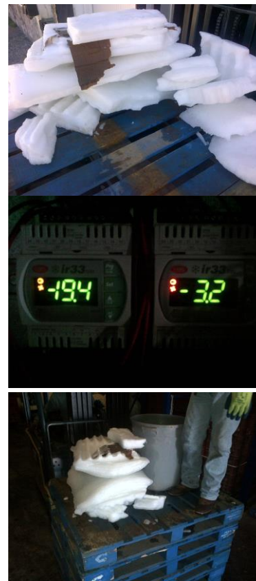
Imagen 6.9 deshielo de paneles de enfriamiento.
