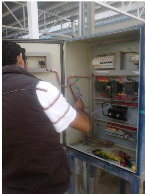
**Figura 23.** Inspección del cable de comunicación en buen estado
