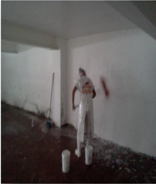
Ilustración 6 Limpieza y desinfección
